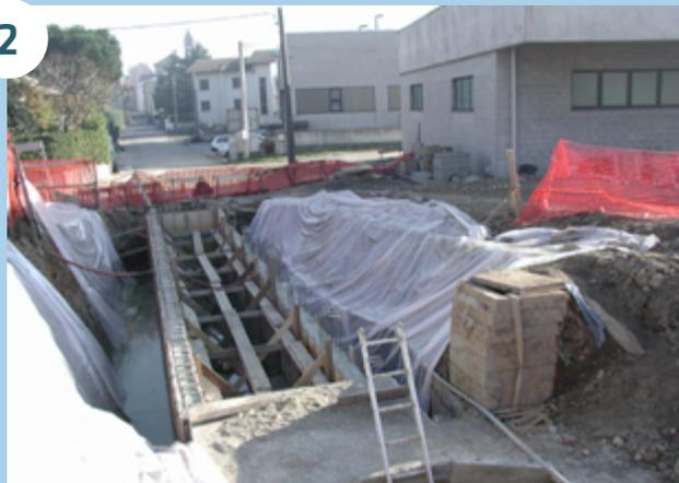
Construção das conexões de entrada e saída entre o supertubo e a rede de drenagem existente
