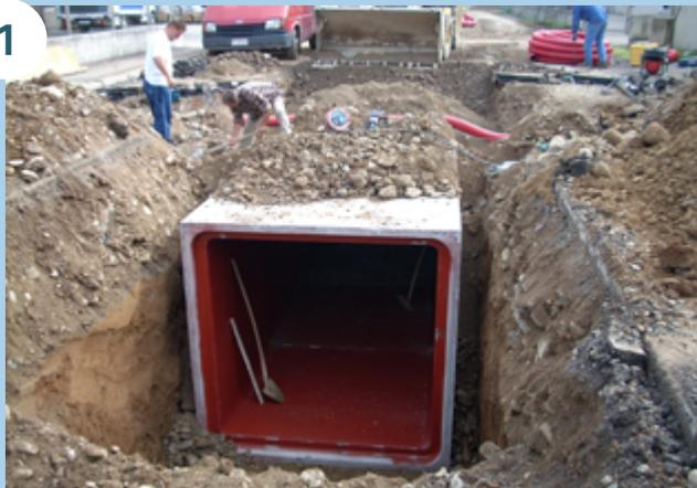
Abertura da vala e alinhamento das peças pré moldadas de concreto
